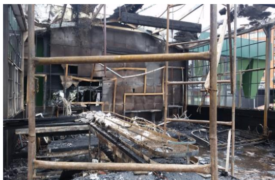
Incendio estructural – Cra. 12 N.º 84ª-57 Fuente IDIGER
