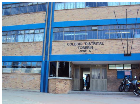
Colegio Distrital Toberín
