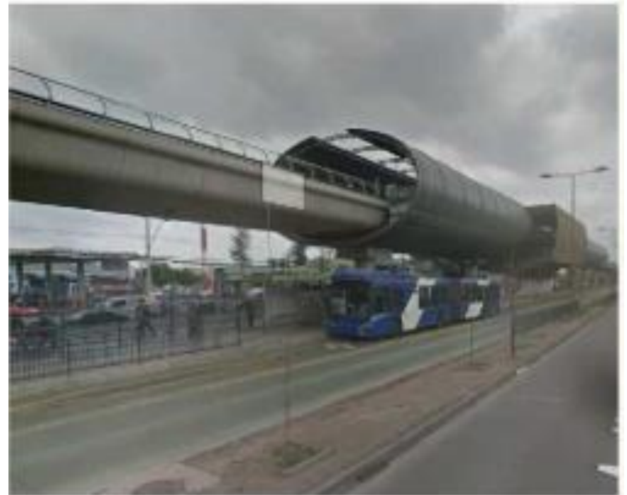
Intermodalidad bus-metro en el viaducto Línea 4
