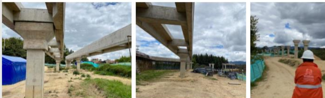
Imagen No. 1 Conexión – pasarela, humedal Juan Amarillo
