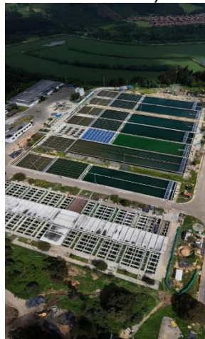
Figura 19. Tren 4. Llenado e inicio de puesta en marcha Tren 4 enero 2024 y Tren 3. Llenado e inicio de puesta en marcha Tren 3 mayo 2024.
