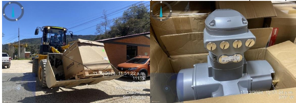
Figura 16. Frente de Obra # 3 – Actuadores para Válvulas Anulares (En Obra).
