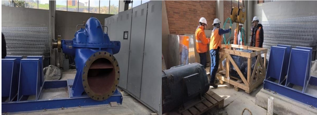
Figura 9. Frente de Obra # 4 – Tercera Unidad Bombeo TAF.
