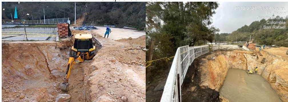
Figura 11. Frente de Obra # 6 – Tanque Salmuera.
