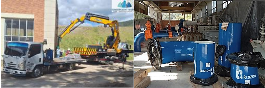
Figura 17. Frente de Obra # 4 – Tubería 36" para Sistema Bombeo TAF (En obra).
