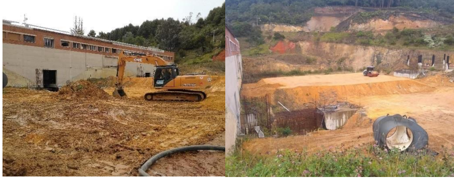
Figura 3. Suministro Material Filtros Nuevos.
