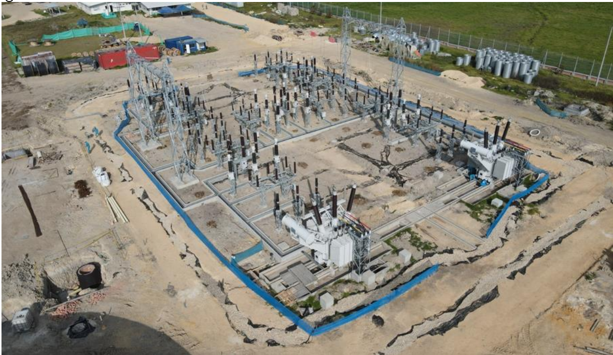
Figura 48. Avance de obra subestación eléctrica EEAR Canoas.
