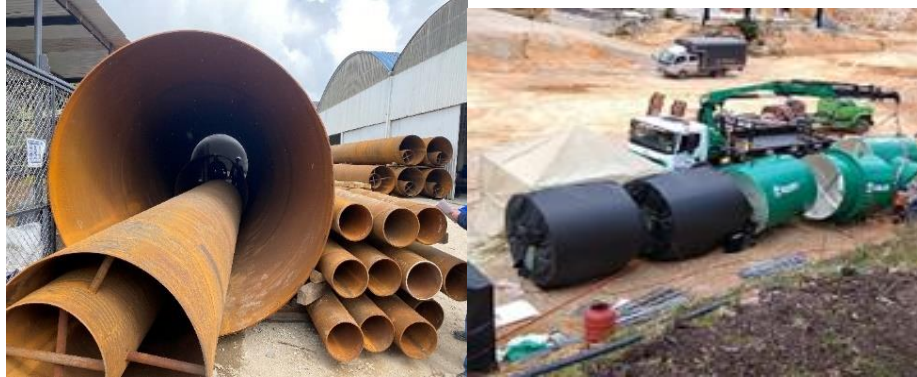
Figura 14. Frente de Obra # 1 – Tubería 96" para la red de agua filtrada (En obra).
