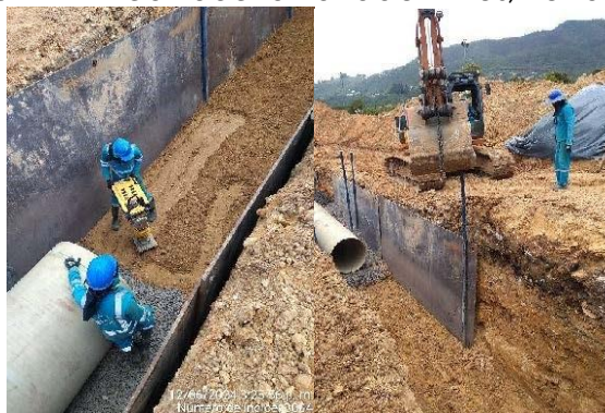
Figura 2. Frente de Obra # 2 – Red Tubería Lavado Filtros, Zona Lagunas.
