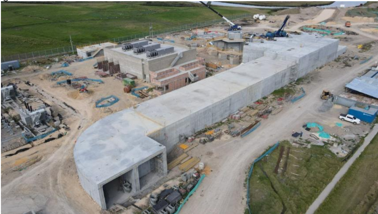
Figura 47. Avance de obra Box Culvert.
