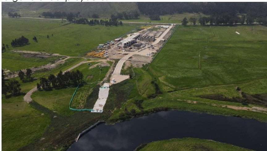
Figura 43. Vista general del proyecto.
