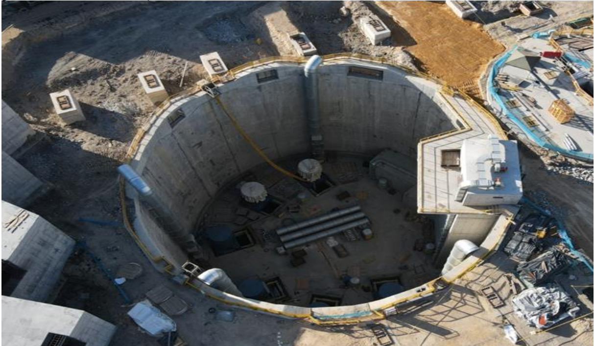
Figura 44. Avance de pozo de bombeo EEAR Canoas.
