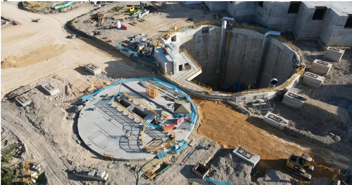
Figura 46. Avance de pozo de cribado EEAR Canoas.
