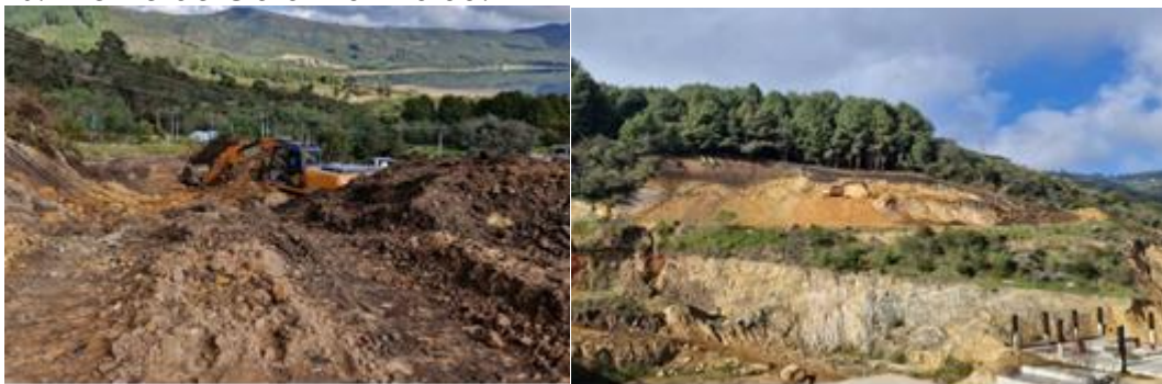
Figura 10. Frente de Obra # 5 – Talud.
