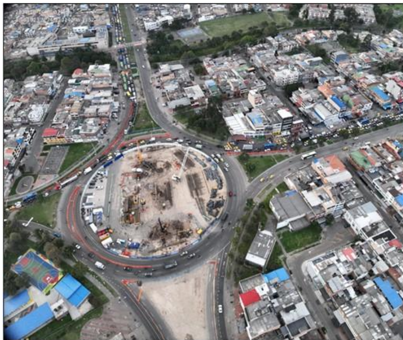
Estación Metro No. 8- Nave Central
