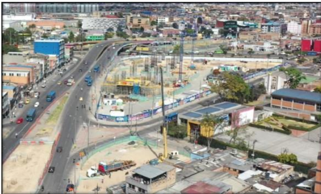
Estación Metro No. 6 – Nave Central
