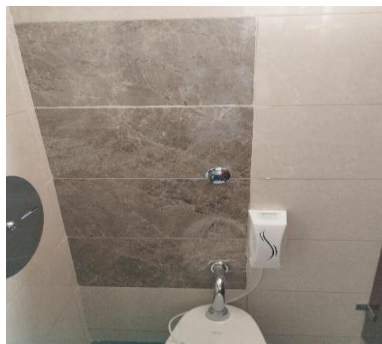
Imagen 23. Arreglo escape baño Fuente IDIGER
