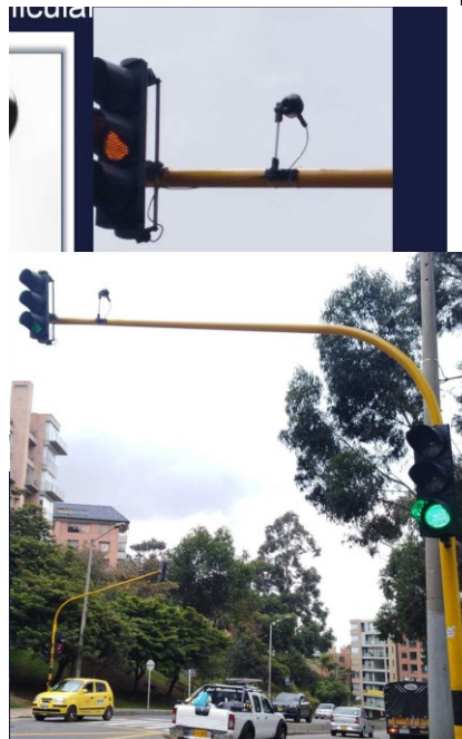
Imagen 1. típica de video detector instalado en poste de semáforo
